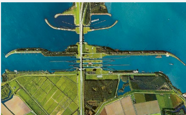
Som försvar mot stranderosion byggs sandbankar upp i Nederländernas deltaområden, vilket har stor betydelse för den biologiska mångfalden.
